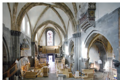
Die Bauarbeiten im Innern der Kathedrale
