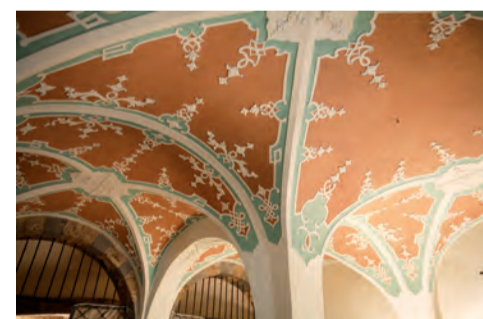
Reich verzierte Gewölbedecken in der Krypta der Kathedrale
