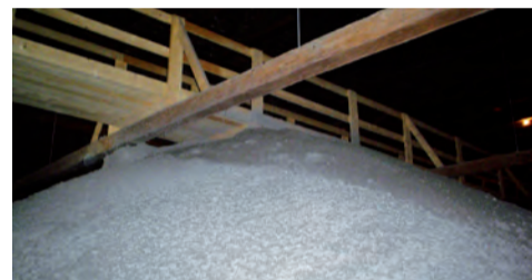
Gleichmässige isofloc-Dämmschicht (Bild: J. Schönenberger)
