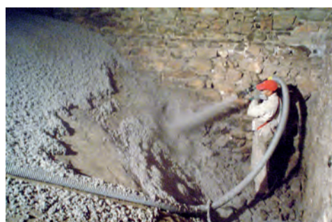
isofloc wird gleichmässig aufgesprüht (Bild: J. Schönenberger)
